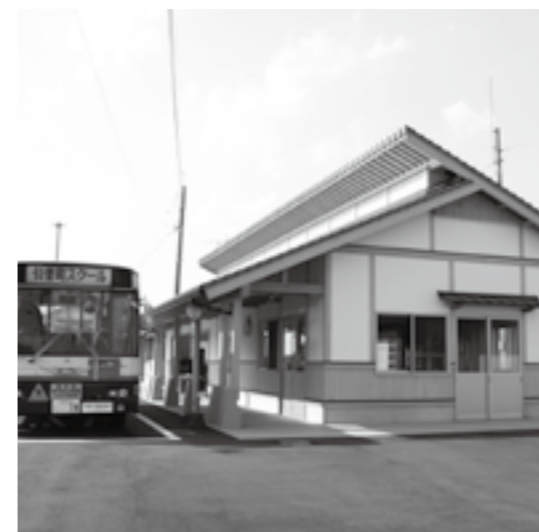
完成した岸本駅前待合施設
