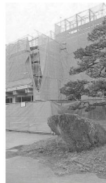
改修工事：溝口小学校
