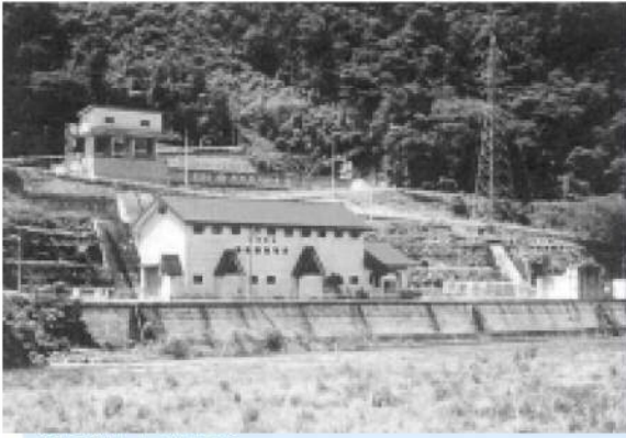
新幡郷水力発電所
