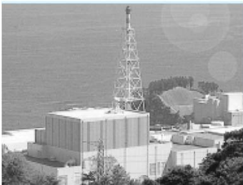
島根原子力発電所
