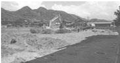
新築体育館着工前の整地（溝口小学校）
