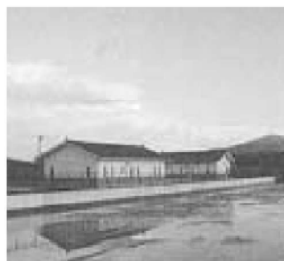
農業集落排水処理施設（遠藤地区処理施設）
