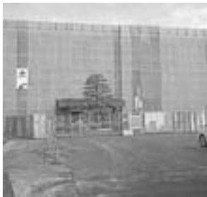
岸本中耐震改修事業
