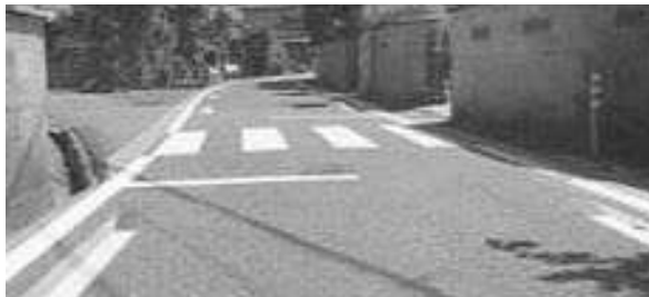
路肩グリーン舗装新しい注意表示
