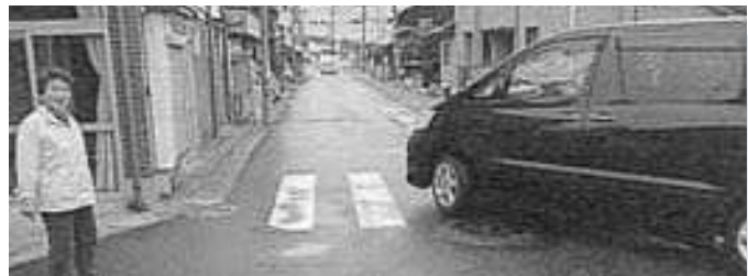
町道岸本停車場線道路改良事業 L = 180m、岸本駅前
