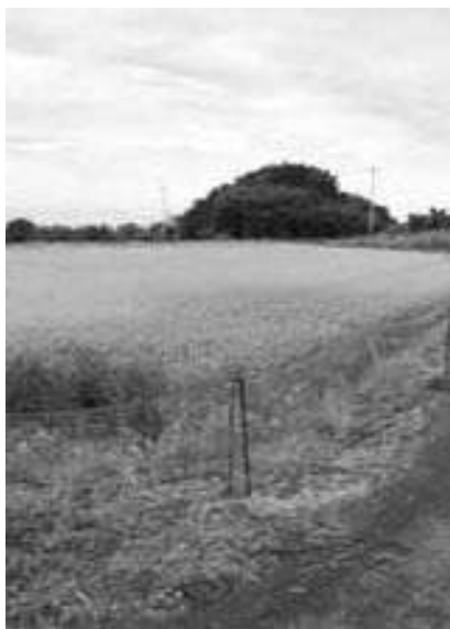
イノシシ用電柵取付け
