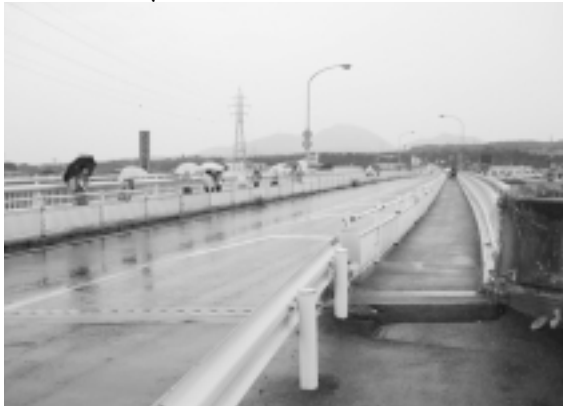
大寺側から見た伯耆橋
