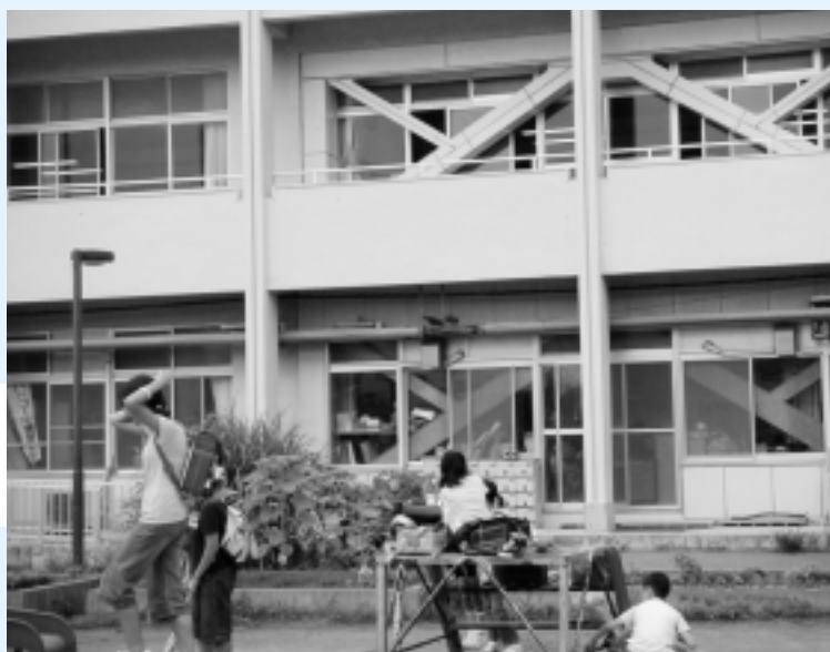
鉄骨ブレース補強
