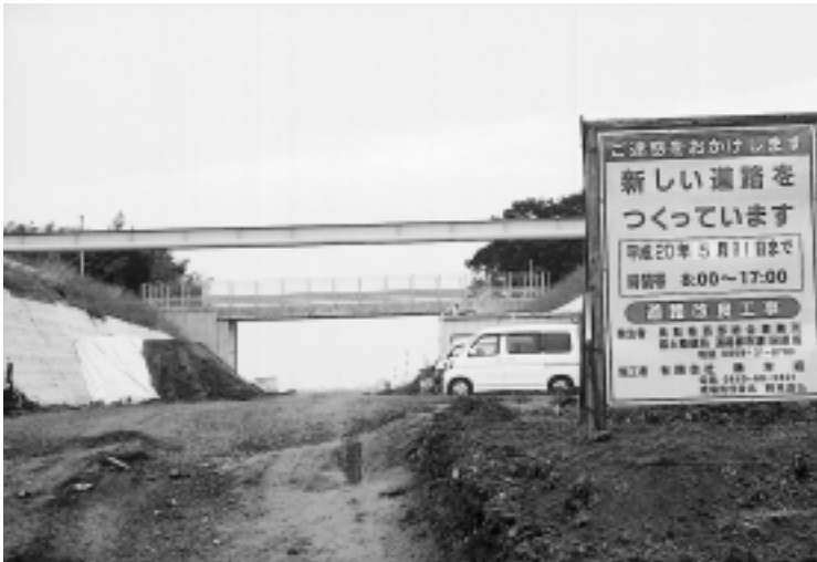
181号線バイパス工事
