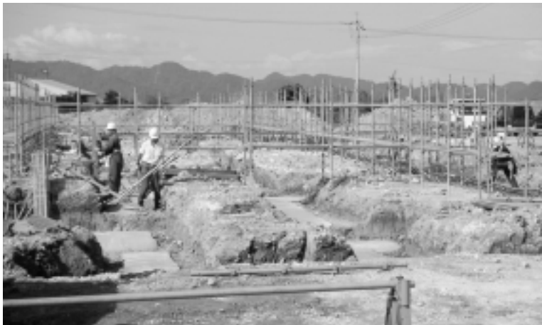
こしき保育所建築工事
