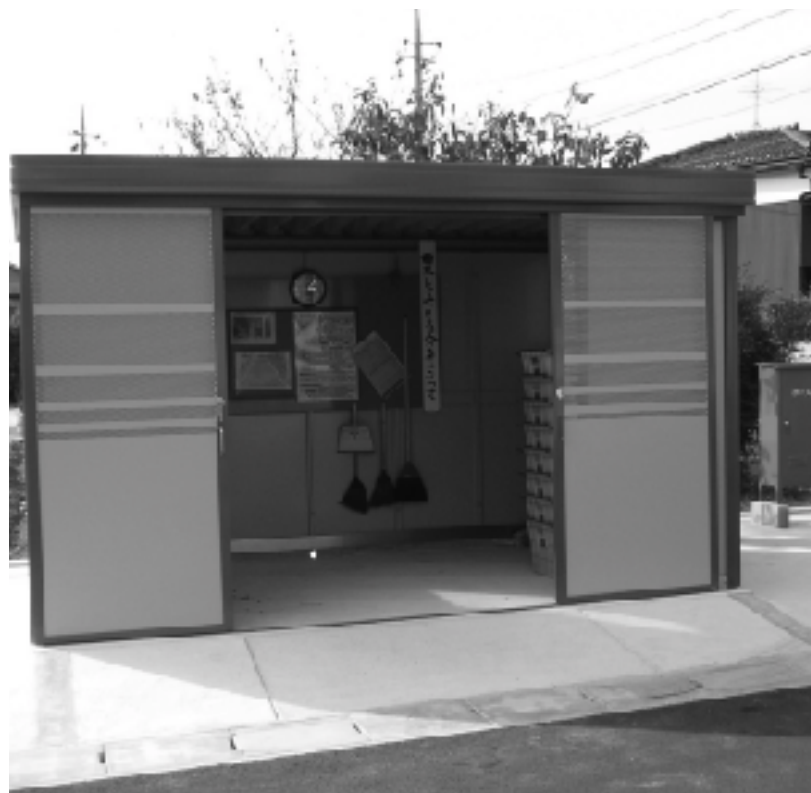
全町に早急なゴミステーションの設置が望まれる
