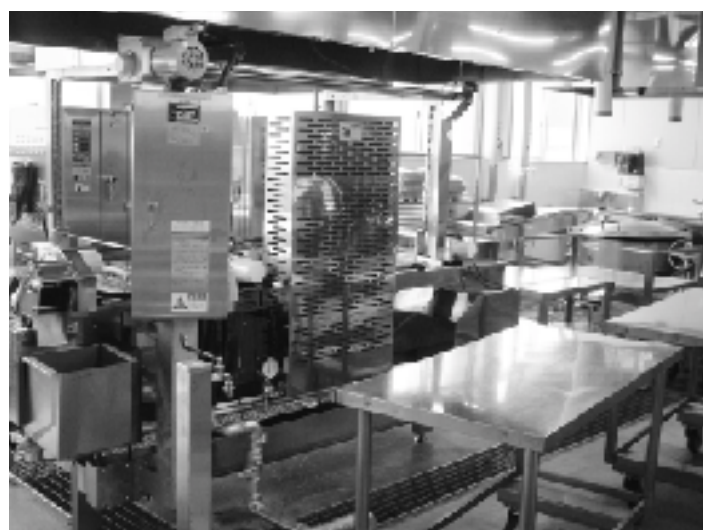
改装になった給食センター内部
