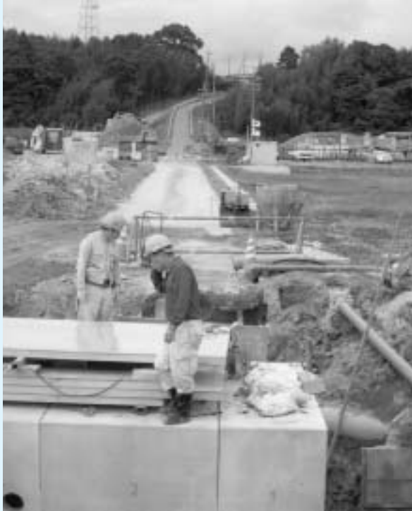
坂長九号線工事現場(坂長)
