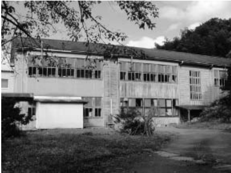
二部小学校木造校舎
