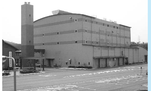
エコスラグセンター（岸本地内）
