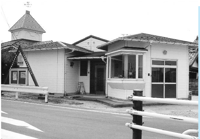
廃止となった岸本駐在所
