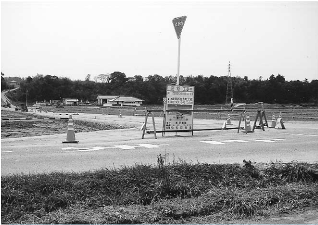
町道坂長9号線工事現場
