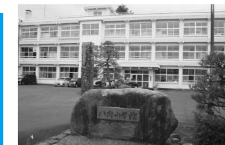
空調などの改修予定の八郷小学校
