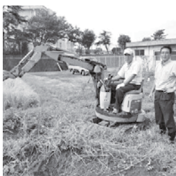
ミニパワーショベルで穴掘り
