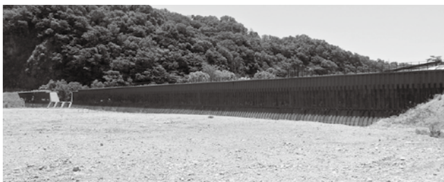
砂防堰堤は写真に入りきらないほどの長さです
