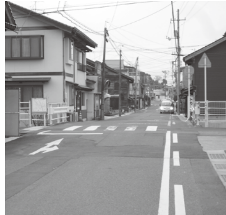
町道改良工事（岸本4号線）
