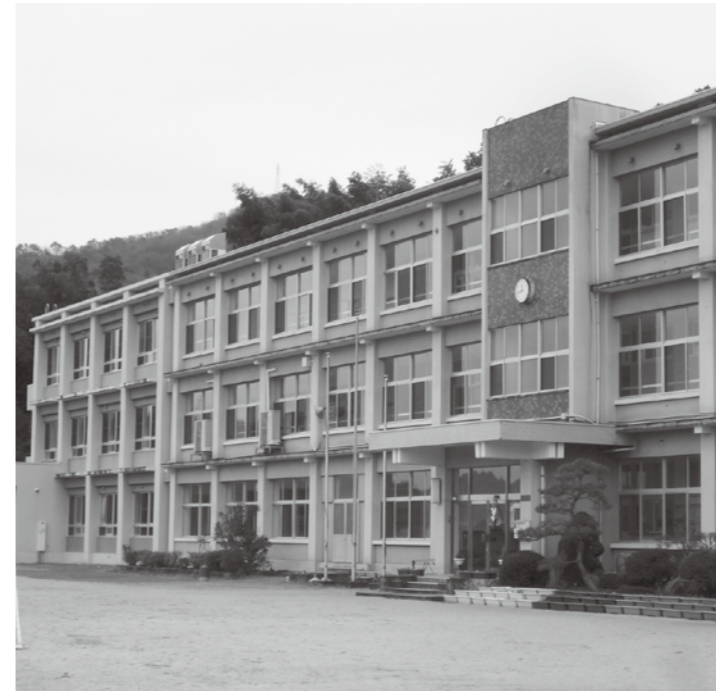
改修予定の二部小学校
