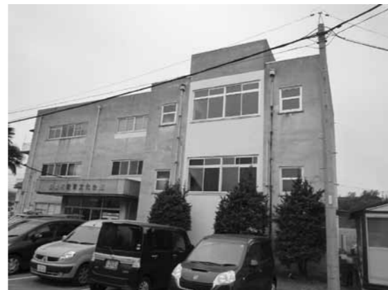
解体予定の教育文化会館
