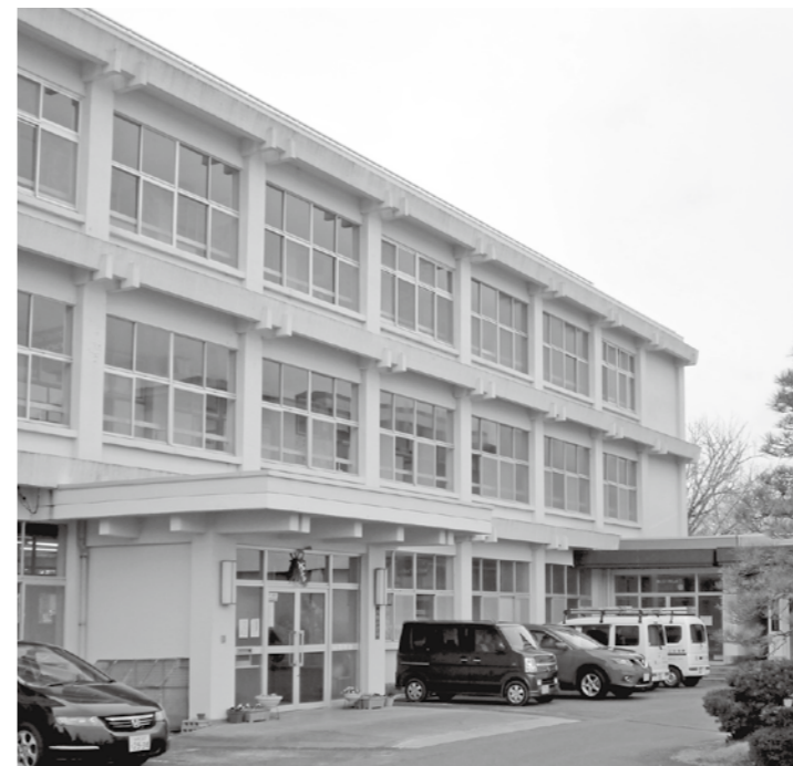
改修予定の八郷小学校
