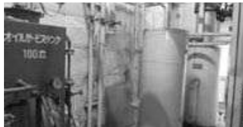
給湯・暖房設備改修（溝口保育所）
