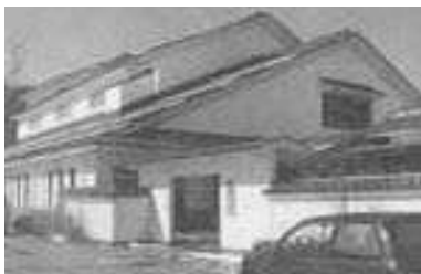
屋根、外壁の修繕（鬼の館）
