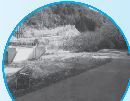
町道籠原栃原改良 事業
