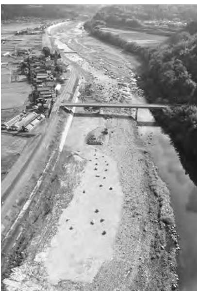
河床掘削工事 (三和橋周辺)
