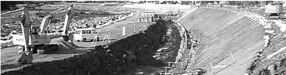
日野川堤防工事の状況 (写真提供：国土交通省日野川河川事務所)
