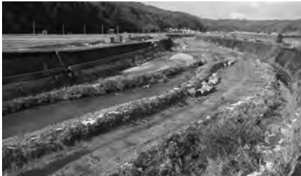
野上川河床掘削（二部地区）
