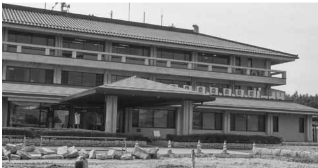
本庁舎の大規模改修工事
