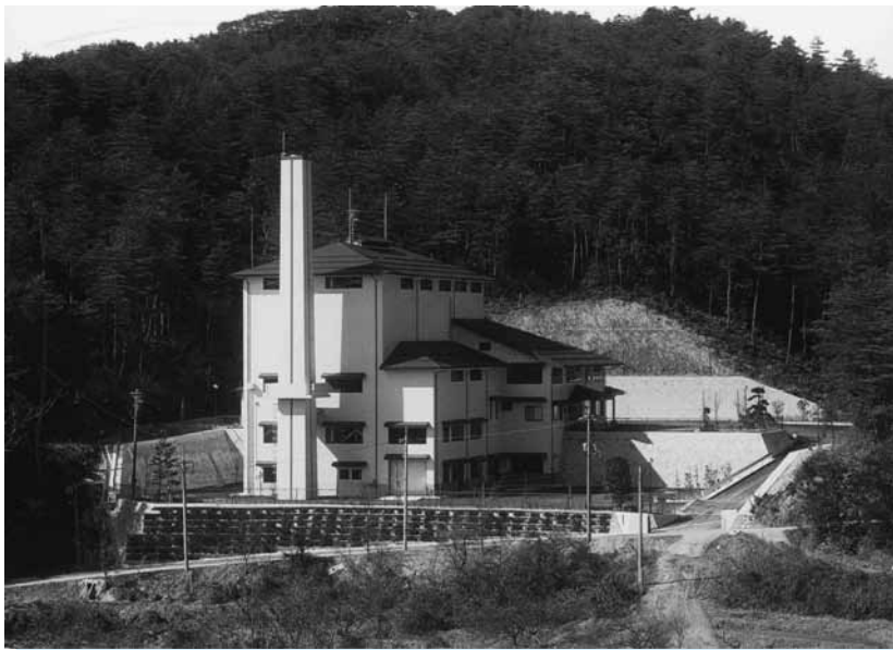
現在の可燃ごみ焼却場（南部町所在）
