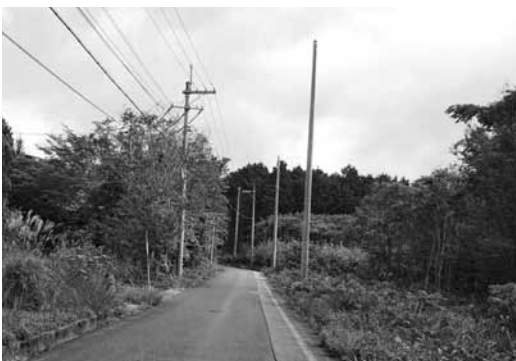
送電のための電柱工事（宮原）
