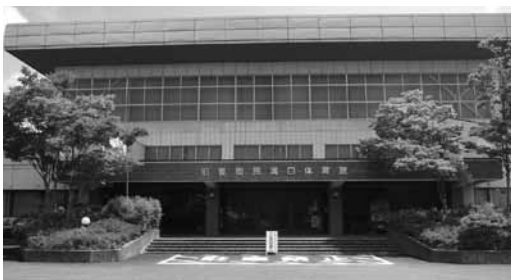
溝口体育館改修
