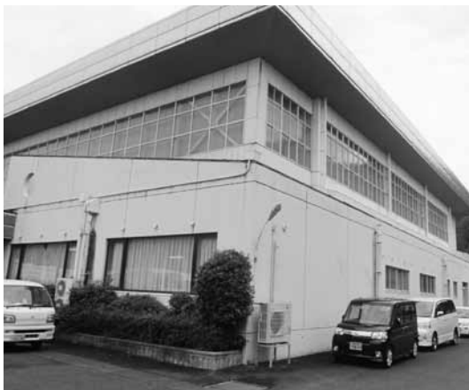
大規模改修の設計がはじまった溝口体育館
