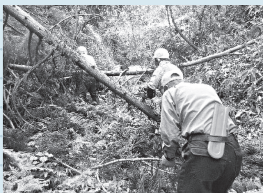
大がかりな作業でした
