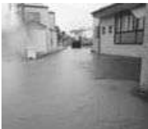
豪雨時道路が冠水
