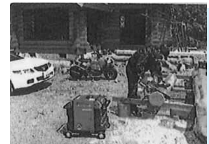
非常用の発電機(岸本区)
