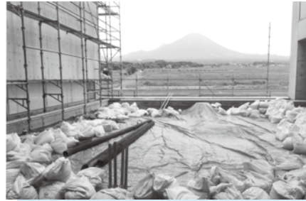
外壁等改修工事中の写真美術館
