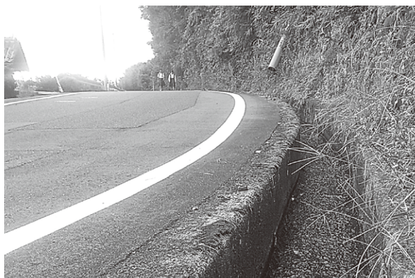
こしき団地付近の水路
