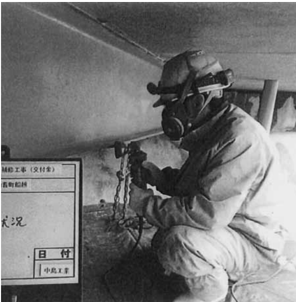
橋のコンクリートのヒビ割れなどの補修 (三反田橋・船越)
