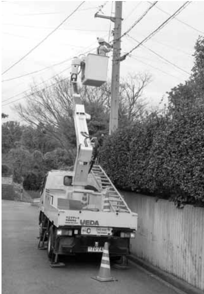
高所作業車による有線放送設備点検
