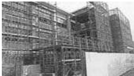
校舎改築 (溝口中学校)
