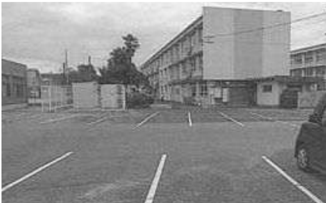
改修を終えた岸本小学校
