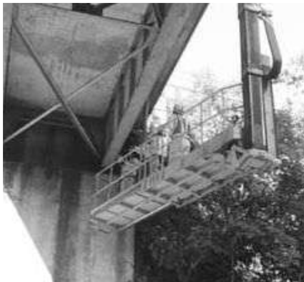
町道橋梁調査点検の様子
