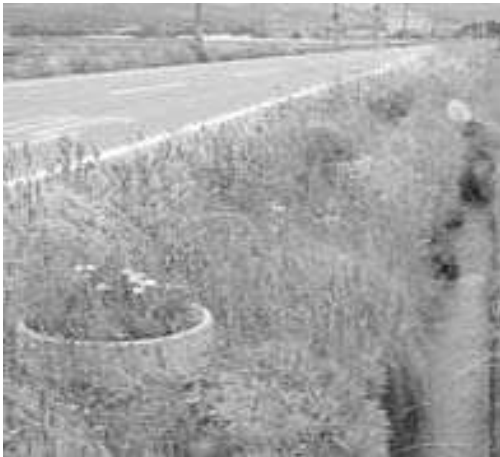
町道岸本大原線の花壇ヒューム管
