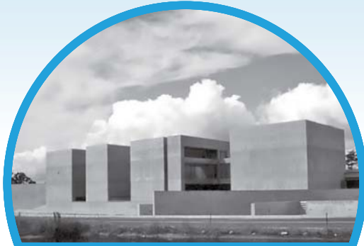
写真美術館改修事業(新規) (エレベーター改修工事) 3,714万円
