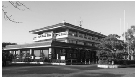
本庁舎改修予定
