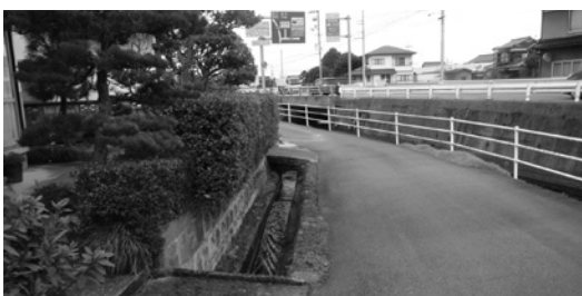
生活用・農業用に供されている水路・道路
